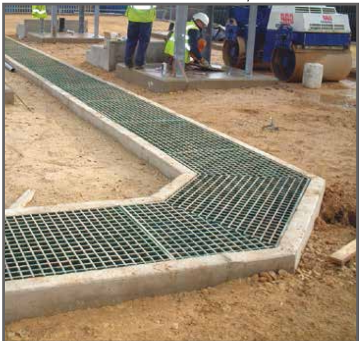
Después de la Instalación de las Cubiertas de FRP para Trincheras
