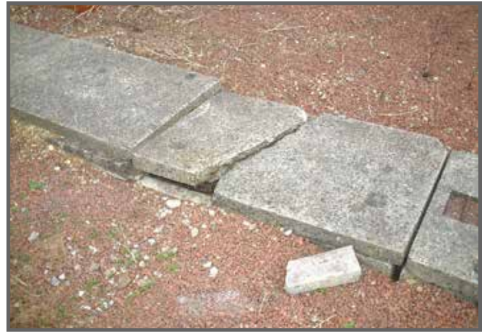
Cubiertas Tradicionales de Concreto para Trincheras
