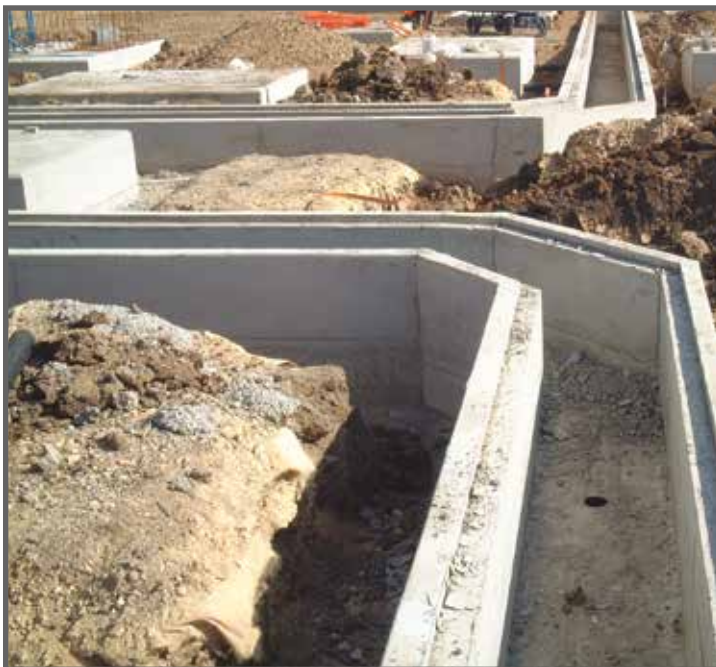
Trincheras de Servicio Público Durante su Construcción
