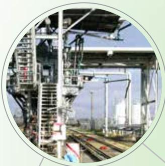
Los productos antiderrapantes y resistentes a la corrosión de Fibergrate®, incluyendo escalones, barandales, rejillas y perfiles estructurales proporcionan plataformas de acceso a los vehículos de combustible.
