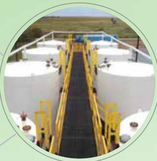
Los escalones Fibertred® y la rejilla moldeada Fibergrate proporcionan pasos y plataformas resistentes a la corrosión en todas las instalaciones químicas.
