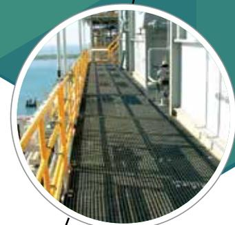
Los productos moldeados Fibergrate® y los productos pultruidos Safe-T-Span® se utilizan en pasos, plataformas, pasos de gato y escaleras en plataformas semisumergibles gracias a sus propiedades de resistencia a la corrosión y ligereza.
